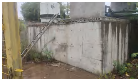
事故应急池现状照片
