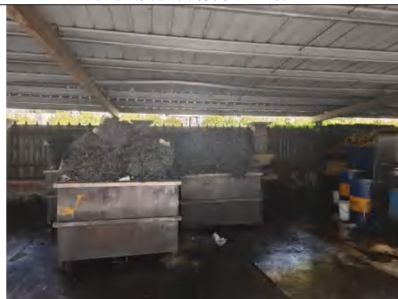
一般固废专用仓库内部
