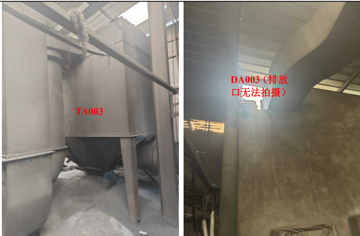
图 2.4-2 企业现有项目抛丸粉尘布袋除尘装置现状照片
