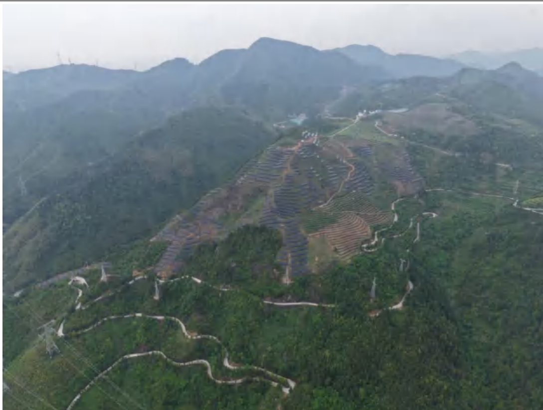
3#光伏区 2026 年 5 月 30 日航拍照片
