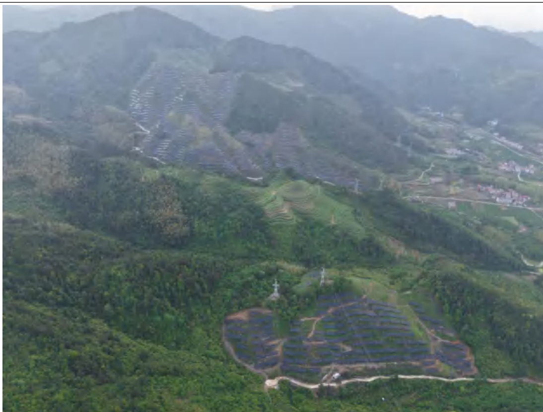
1#光伏区 2026 年 5 月 30 日航拍照片
