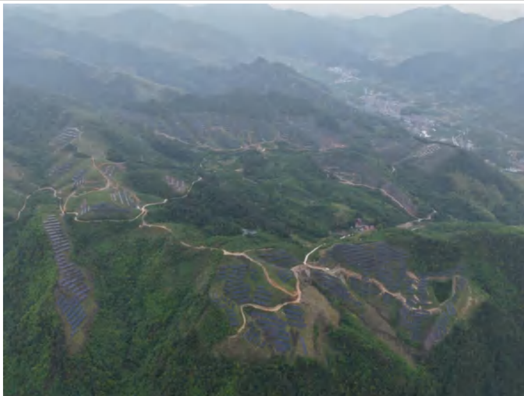
2#光伏区 2026 年 5 月 30 日航拍照片
