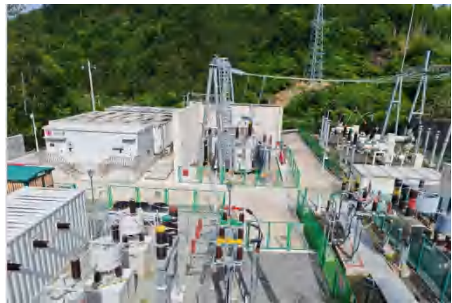
升压站全貌图
