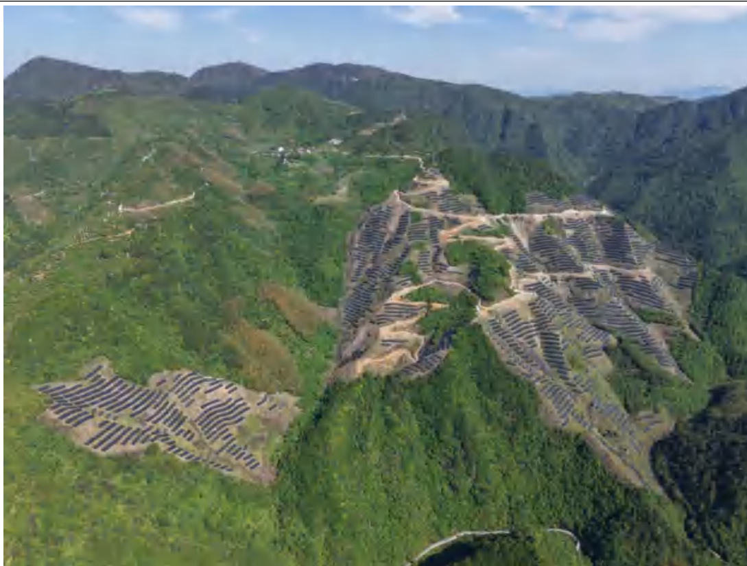
4#光伏区 2026 年 5 月 30 日航拍照片
